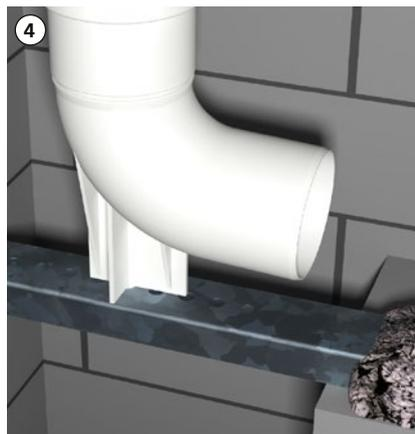
Stützbogen durch die Schachtöffnung, mit dem Dorn, auf die Schiene setzen (Dorn muss in einem Loch der Auflageschiene sitzen).
