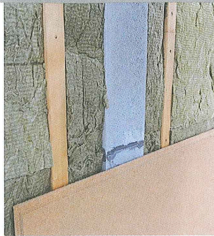
Durchgängige Außendämmung: Ansicht vor Anbringung der 60-mm-Holzfaserdämmplatten als Putzträger. Skobifix WDV ist in die Außendämmung integriert. Die Abgasleitung im Inneren des „Brennwert-Schornsteins“ ist demontierbar.
