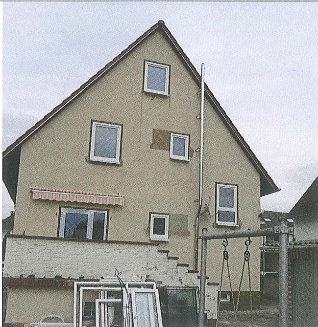
Vorher: Das Edelstahl-Abgasrohr für die Gas-Brennwertheizung verlief ursprünglich außen am Haus entlang.
