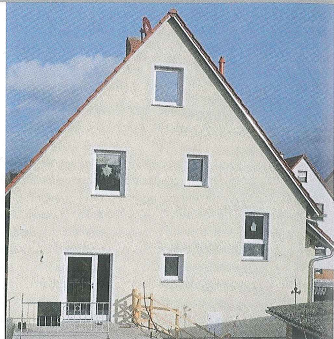
Nachher: Der ehemalige Außenkamin ist in der Dämmung verschwunden. Damit ist eine geschlossene Außenfläche mit einem optisch ruhigen Eindruck entstanden.
